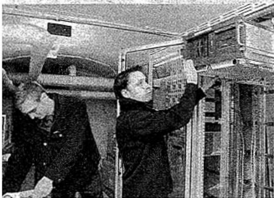
Björn Weinhönig und Thomas Badock von der Dresdener Firma Saxocom bei der Serverinstallation im Keller des Rathauses Pegau. Foto: hhk
